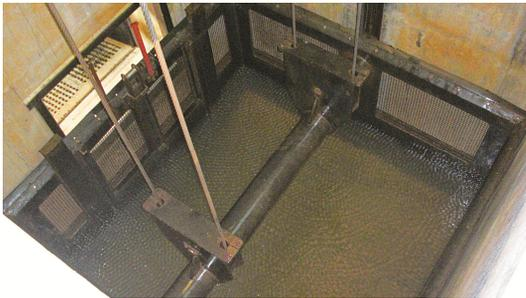
圖 4 機械式升降魚梯載魚槽
