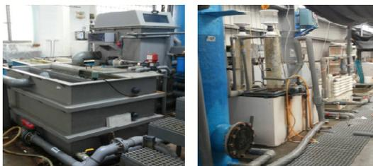
圖 6 弱電淨水 (左) 與傳統形式過濾系統 (右)
