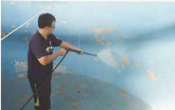
圖 8-8 育苗模場水池於放養前以高壓水柱進行清洗
