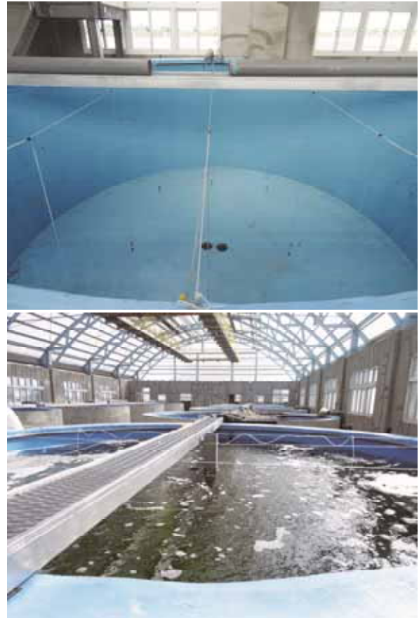
圖 8-7 育苗模場水池打氣管設置，使養殖水體都能獲得充足溶氧
