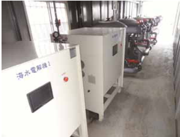
圖 8-6 石斑魚模場電解水消毒過濾系統
