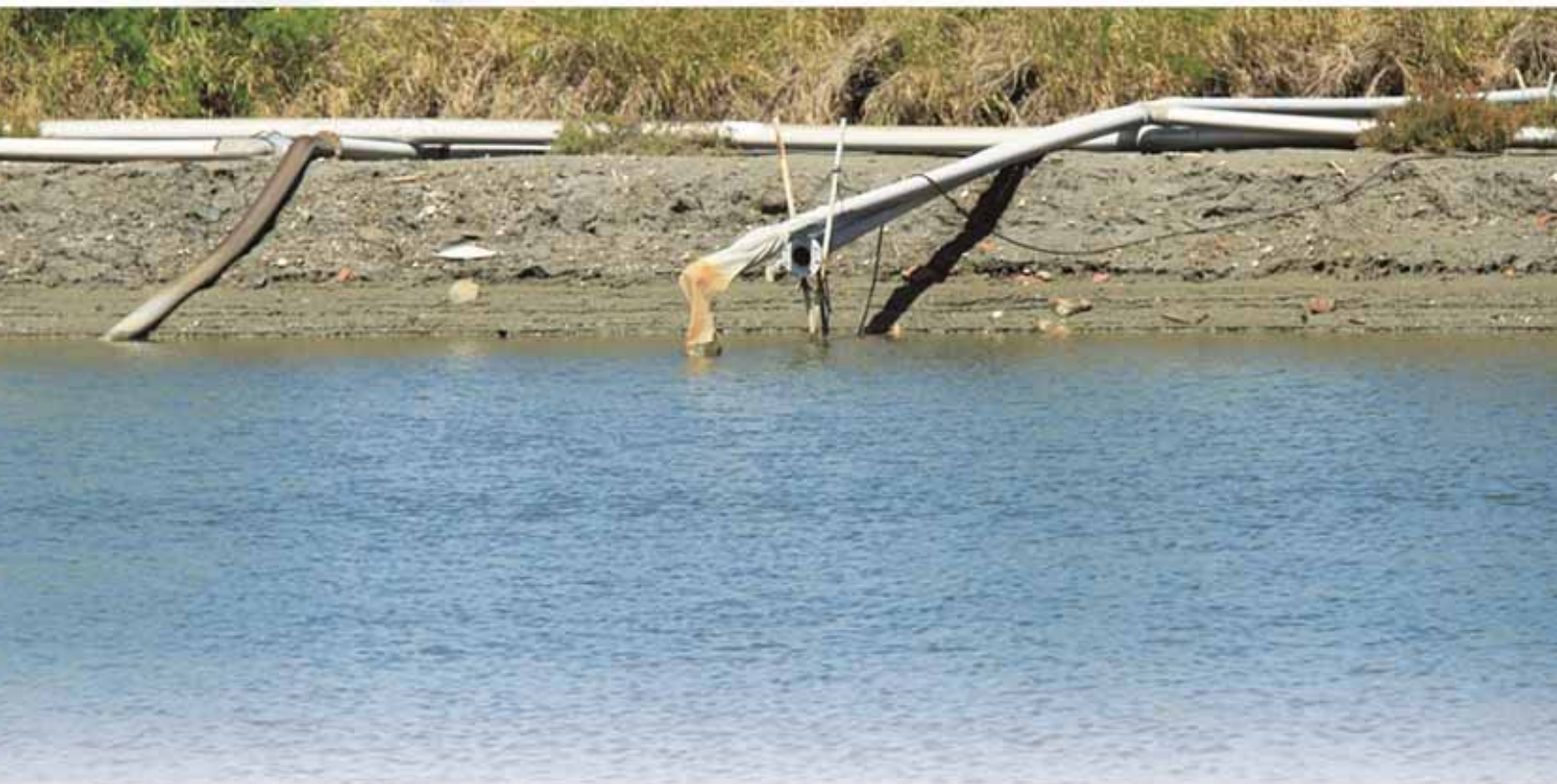
圖 5-5 進水口需使用長型濾水網袋，至少使用 100 網目加以過濾小型生物及其他物質
