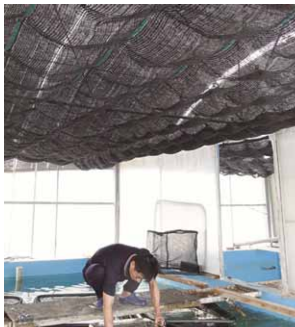
圖 4-4 塑膠溫室的黑色遮陽網可用於穩定室內溫度，減少陽光直射的高溫問題
