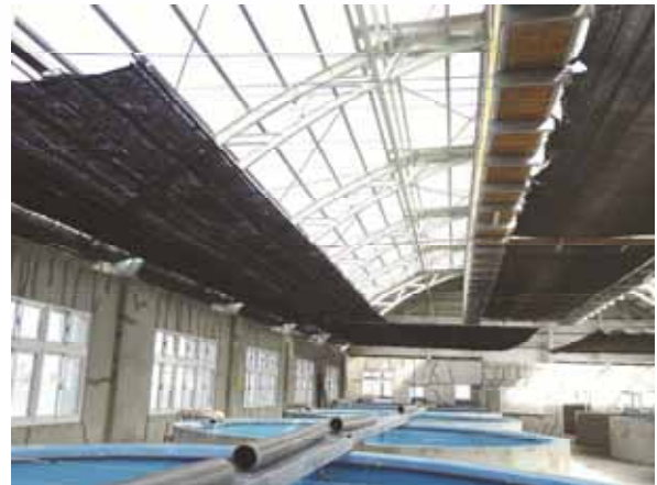
圖 8-4 育苗場室內以遮陽網進行溫度與光線調節，可以用於穩定養殖溫度與水色控制
