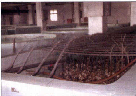
圖 1 海水以浮球液位控制閥自動噴洒曝氣注入儲水槽並以吊掛牡蠣殼去除鐵質
