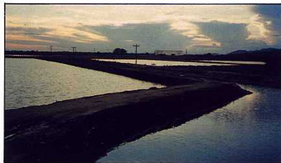
養蝦示範中心蝦池堤岸之一角
