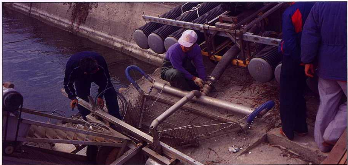
第2代收穫機在坡道上組裝噴管集蛤網與銜接刮板式輸送機之實況
