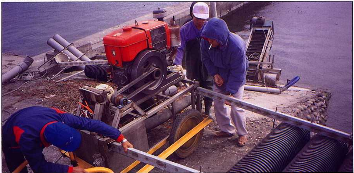
第2代收穫機在下坡道前之路面組裝活動式浮筒架實況
