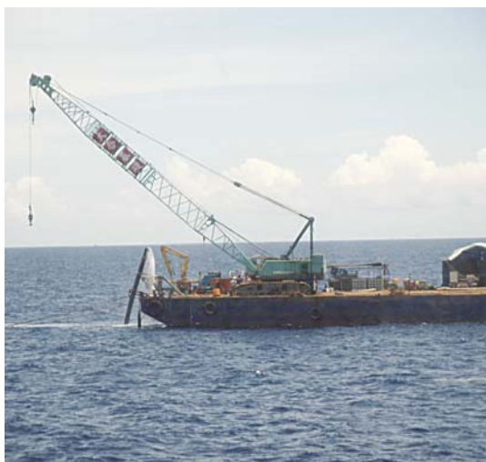
圖 7 從陸域端加壓將原留在管線內之空氣及水排出
