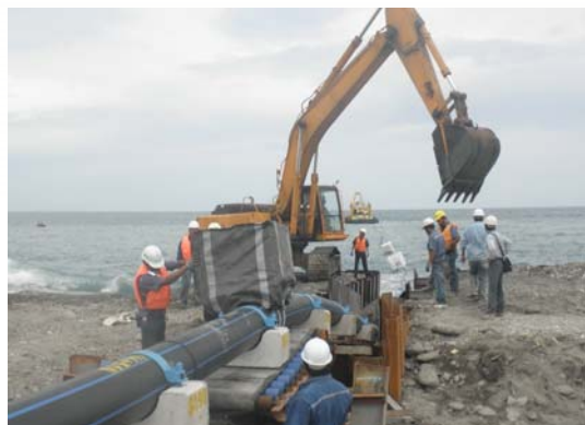
圖1 取水管經輸送帶滑入海中，由大型拖船拖往布管海域
