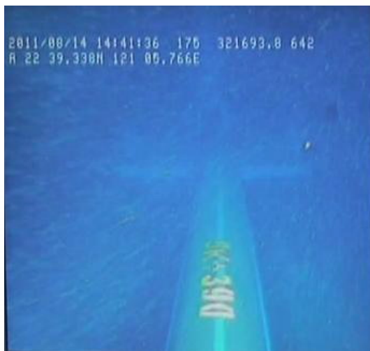
圖 8 取水頭在管線標示 5k+390 附近，垂直座落於海床上
