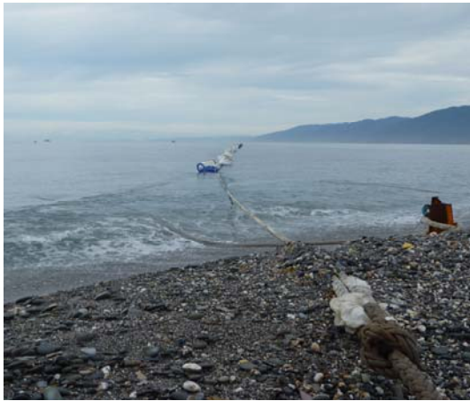
圖 3 近岸端深層海水管拖至離岸水深約 8-9 m 左右之海域定位
