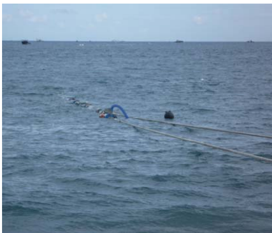
圖 4 近岸端深層海水管開始注水
