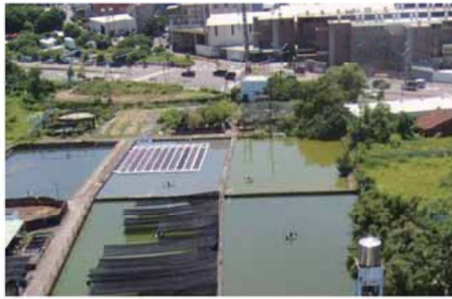
圖 3-3-2 浮筏型太陽光電設施與水車安裝位置空拍圖 （水試所淡水中心試驗池，約0.08公頃）
